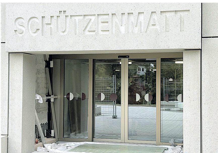
Blick auf den neuen Eingangsbereich. Bis zum Ferienende werden die letzten Arbeiten abgeschlossen sein.
